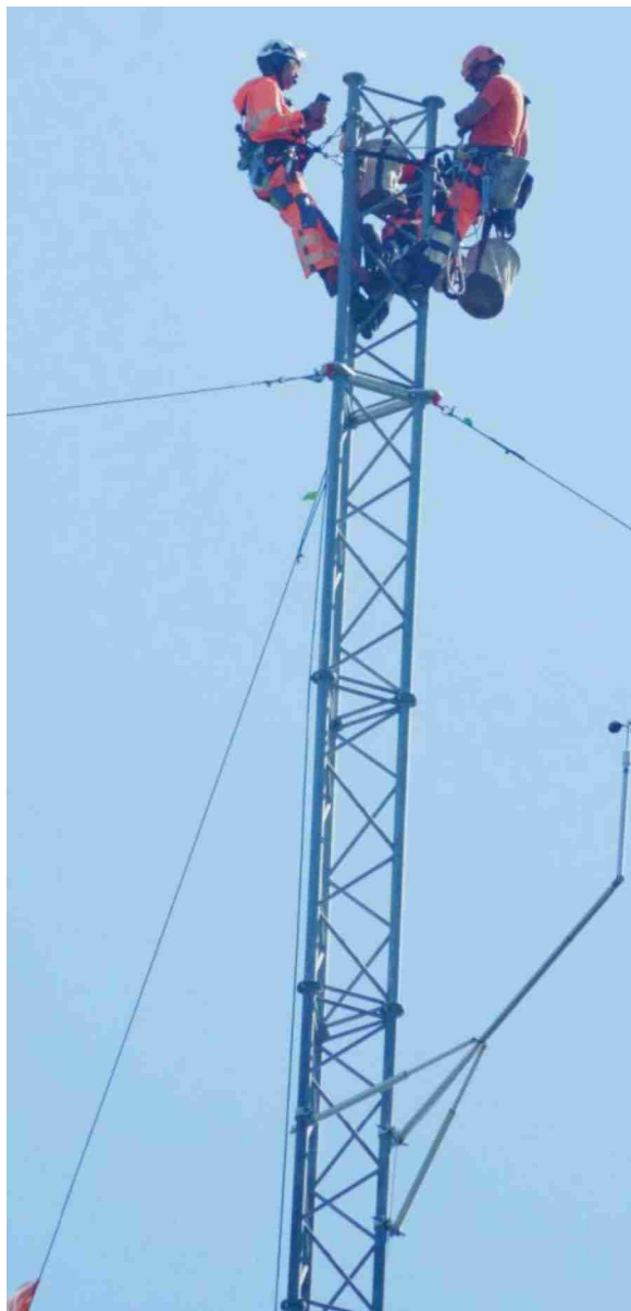
Des alpinistes perchés au sommet du mât installent le matériel de construction délivré par un hélicoptère. YVAN KOHLER
