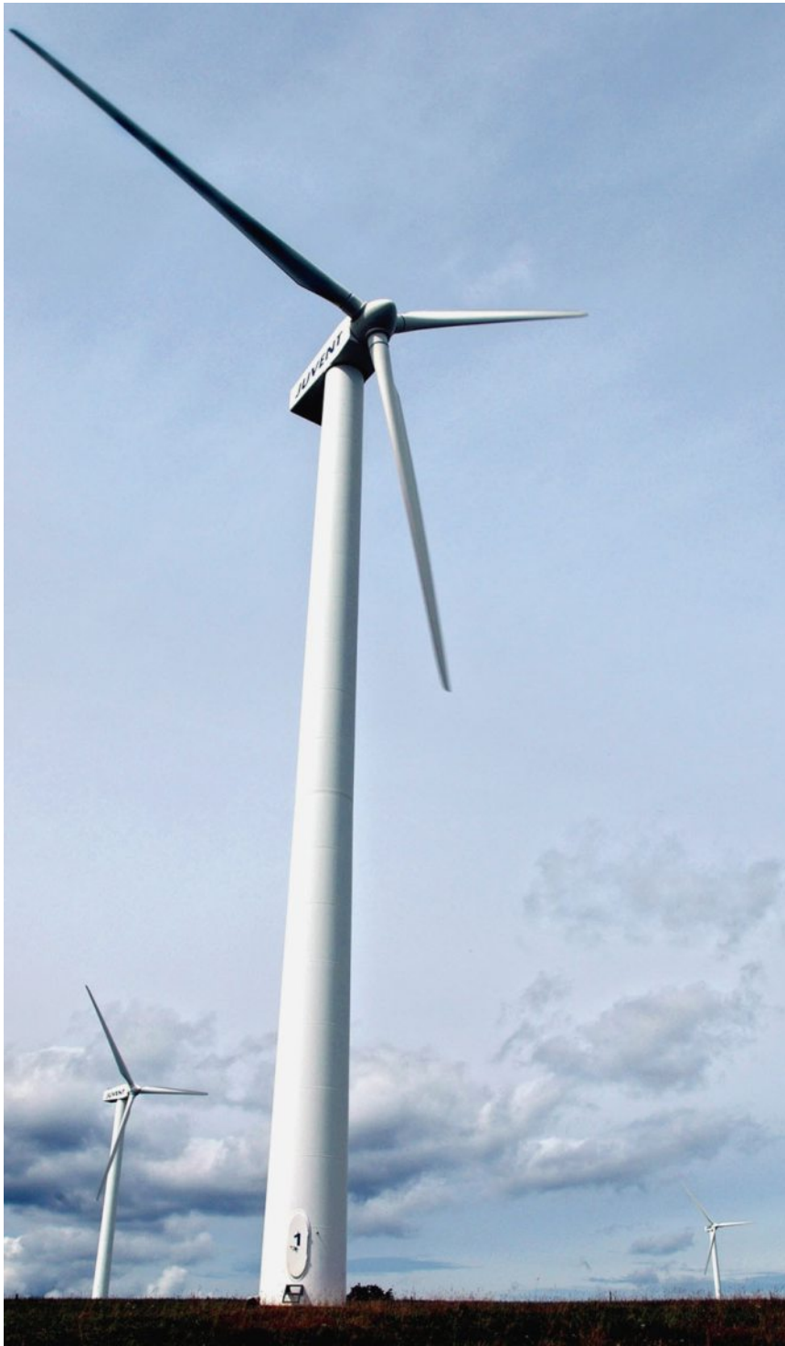
Seules quatre des six machines prévues pourront être érigées. ARCHIVES KEYSTONE
